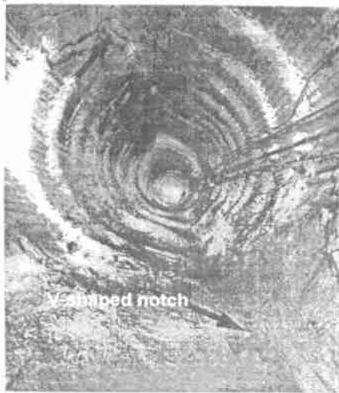
图 8 开挖工程破坏实例 [11]
