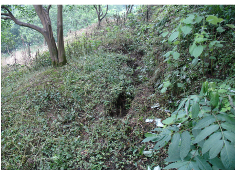
图 4 重庆万州区晒网坝滑坡体 Fig.4 Shaiwangba Landslide in Wanzhou country of Chongqing
