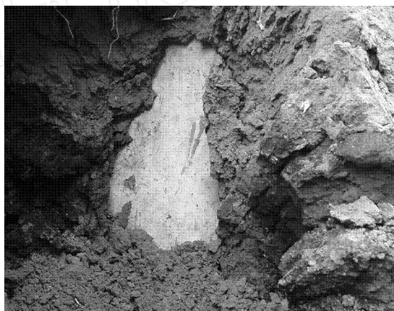
图6 爆炸距离为0.1 m,药量为100 g TNT 当量爆炸试验中爆腔内混凝土管道的裸露面积
