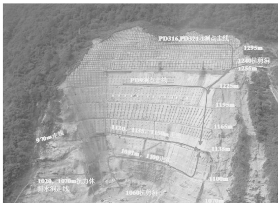
(b) 边坡全貌及微震监测布线
