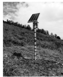
图 5 深部岩土变形测量仪现场安装实物图
