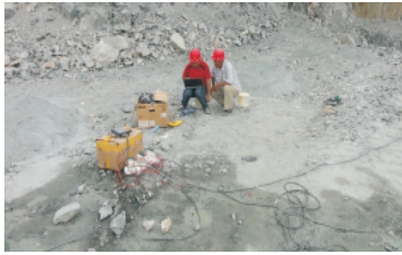
图 3 钻孔注水试验现场数据采集 Fig. 3 Site data collection of borehole water injection experiment
