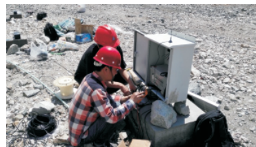
(b) 自动采集传输设备安装
