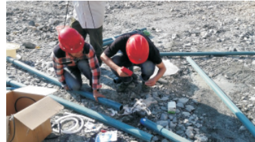
(a) 深部位移测量管拼接及 MEMS 传感器安装
