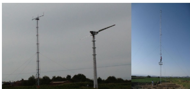
图1 (网络版彩图)外场实验系统,尾流测量平台(左)、实验机组(中)、测风塔(右)
