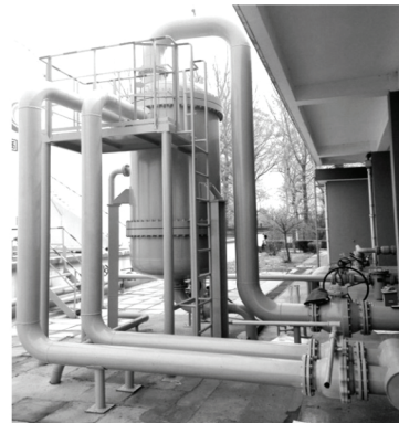
图7 旋流分离器现场安装图
