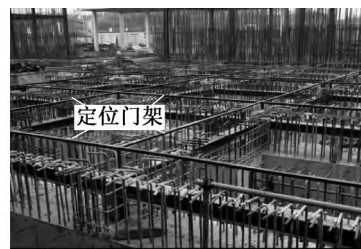
图 5 焊接定位门架
