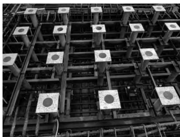
图 7 加载孔预埋件安装
