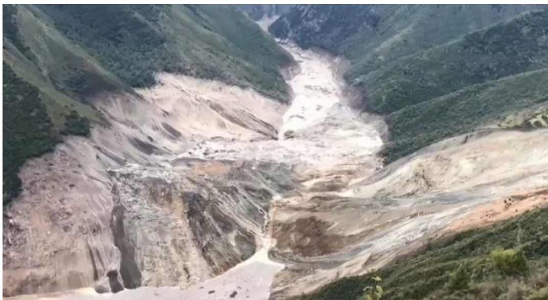
图4 金沙江堰塞湖滑坡体
