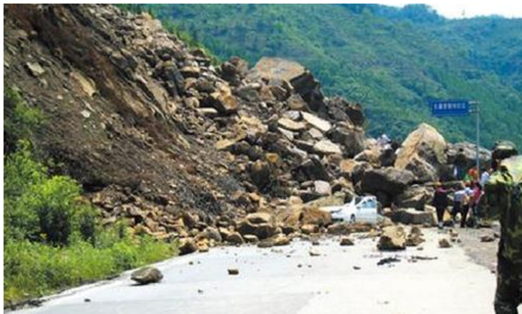
图2 山体滑坡冲毁道路，堵断交通
