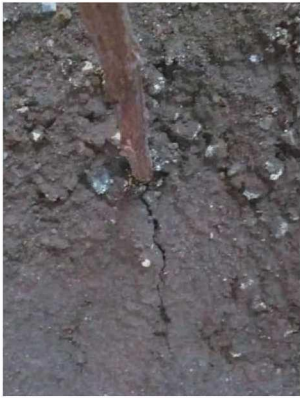
图 5 单根树枝根部的裂缝
