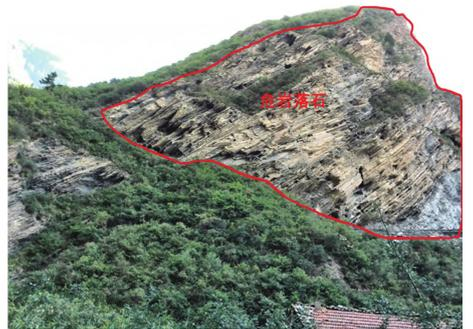
图1 隧道出口危岩落石
