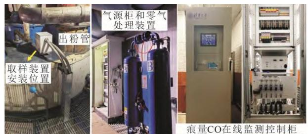
图 8 350 MW 磨煤机 CO 在线监测现场应用示范
