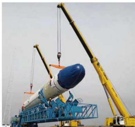
图24 双吊车将“天龙”二号遥一火箭转载到起竖臂
